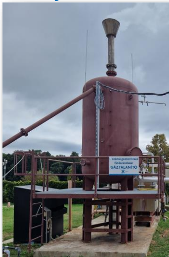
Gáztalanító tartály szigetelés előtt
