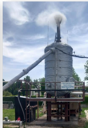
Gáztalanító tartály szigetelés után
