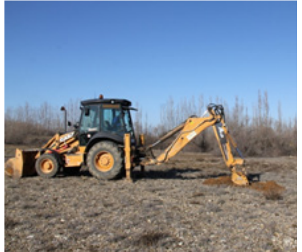
Réalisation des profils de sol dans un ancien fond de carrière abandonnée (Photo Julie Chenot, IMBE).
