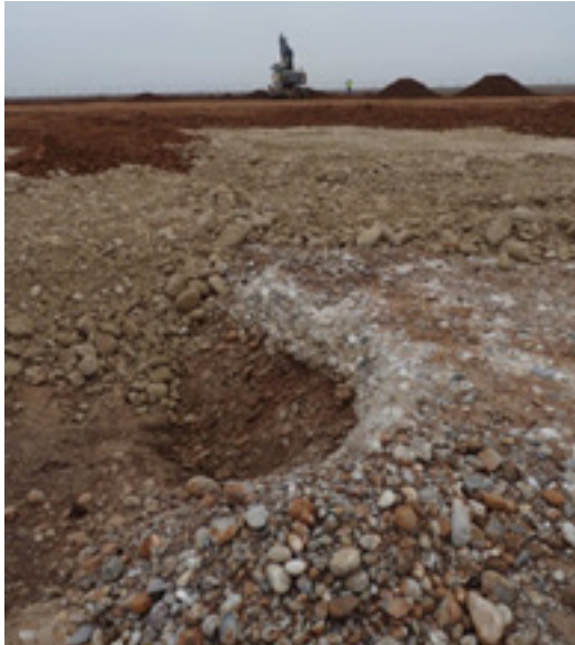
Remise en place des différentes couches de sol au printemps 2011 en provenance d'une carrière proche après enlèvement du sol pollué en 2010 (Photo S. Masson, IMBE).
