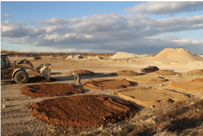
Mise en place des différents mélanges de technosols (Photo. J. Chenot, IMBE-Gagneraud).
